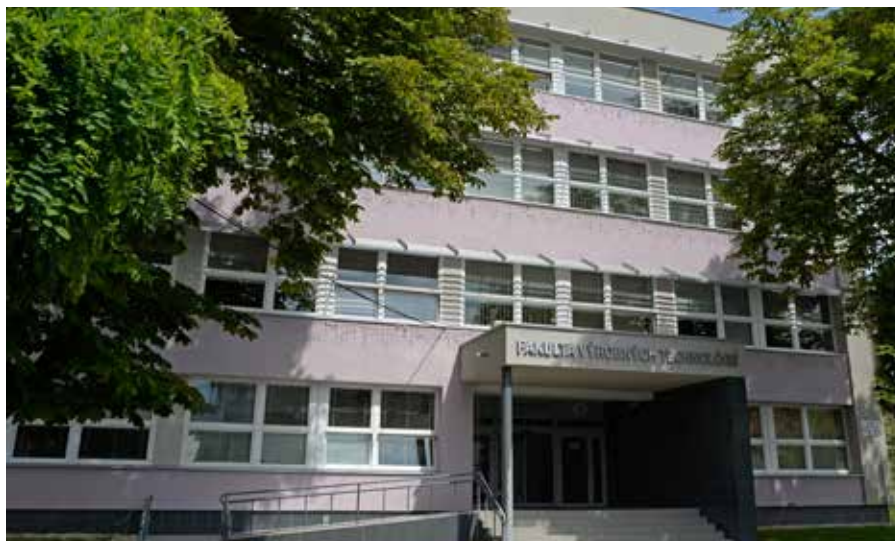
Po rekonštrukcii v roku 2015 After reconstruction in 2015
