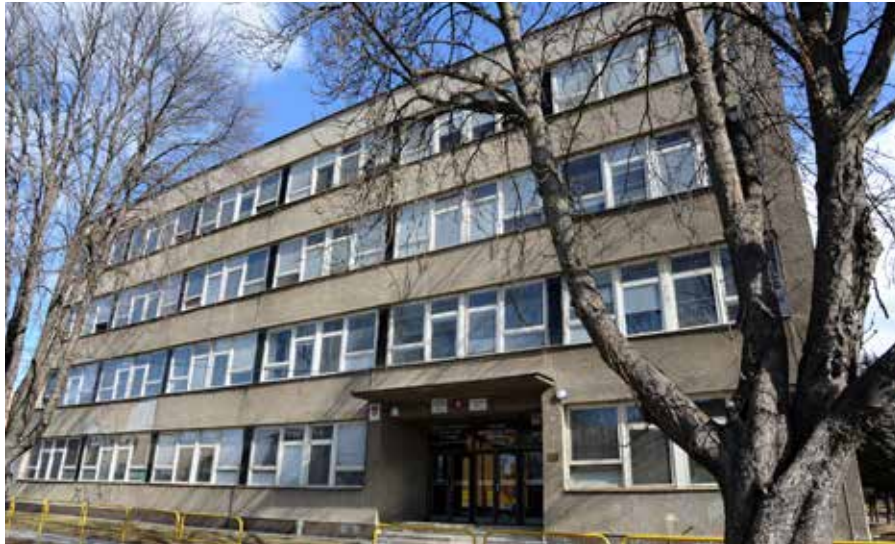
Budova na Bayerovej ulici pred rekonštrukciou v roku 2012 Building on Bayerova Street before reconstruction in 2012
